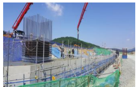
6. 벽체 및 토핑 콘크리트 타설
