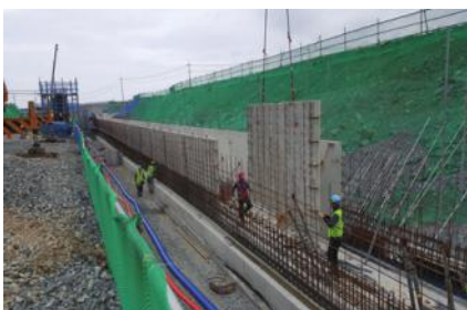
4. PC 벽체 설치
