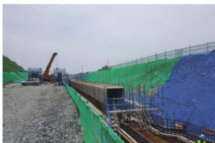
5. PC 슬라브 설치
