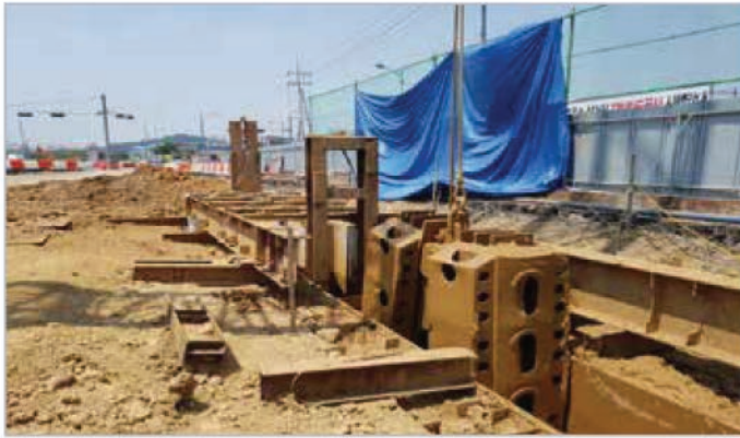
1. 가이드빔 설치 및 굴착
