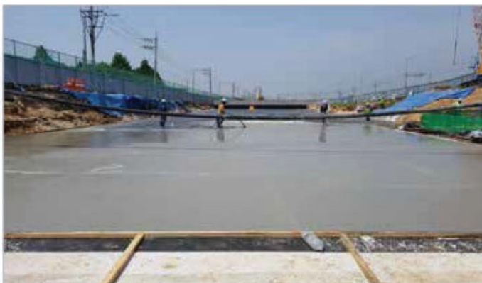
7. 토퍼 콘크리트 타설
