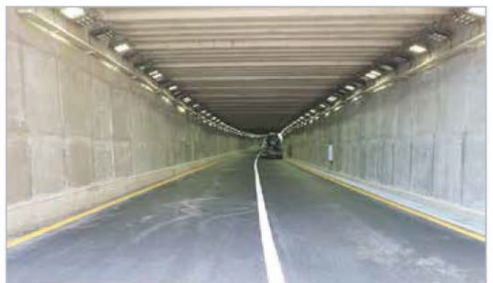
16. BOX-TYPE구간 내부 전경
