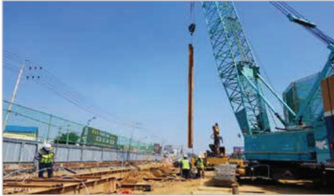
1. 가이드빔 설치 및 앤드파일 근입
