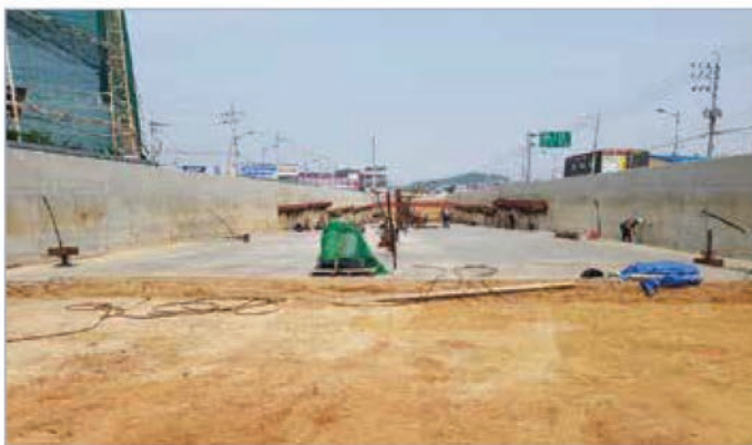
11. U-TYPE구간 버림콘크리트 타설
