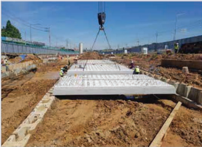
3. 상부굴착 및 PC슬래브 설치
