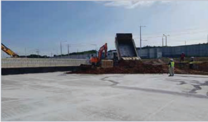
9. BOX-TYPE구간 상부 되메우기
