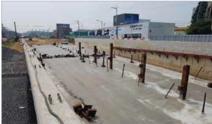
9. U-TYPE구간 하부슬래브 타설(1)
