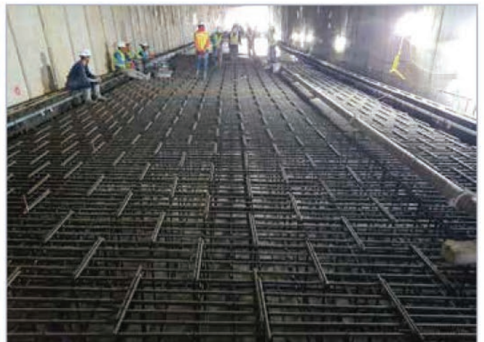
6. 하부슬래브 철근커플러 연결 및 타설
