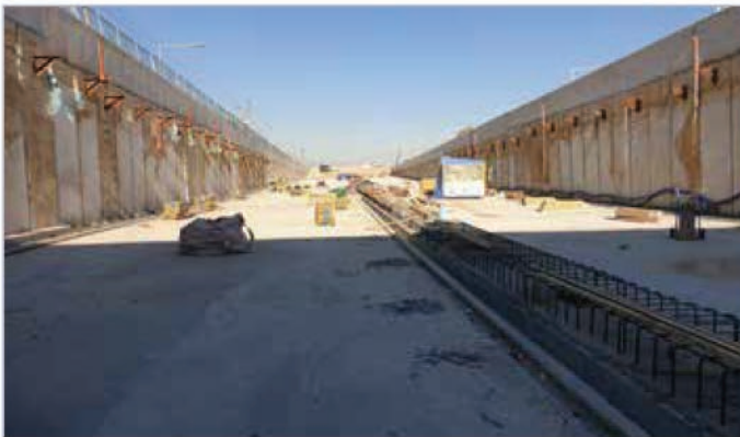
11. 바닥슬래브 타설 및 중분대 설치
