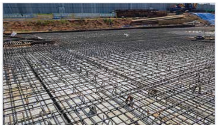
16. BOX-TYPE구간 상부슬래브 철근배근
