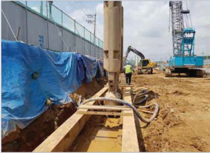
1. 굴착 및 가이드빔 설치
