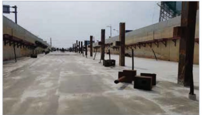
10. U-TYPE구간 하부슬래브 타설(2)
