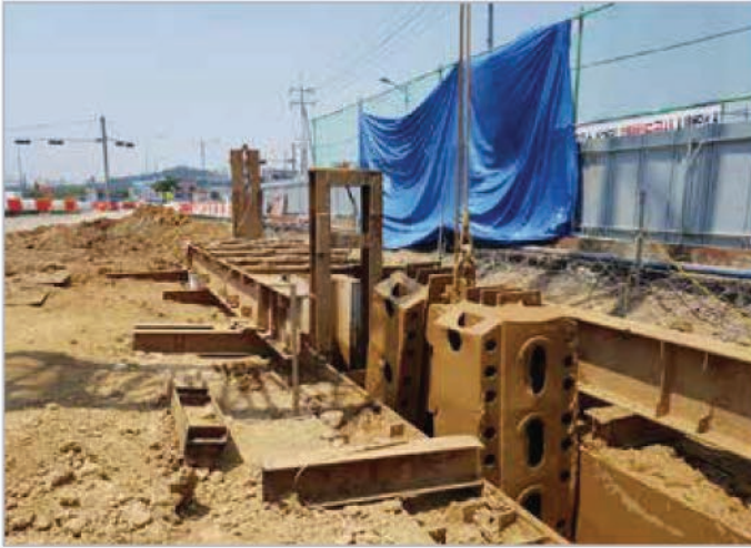
1. 가이드빔 설치 및 굴착
