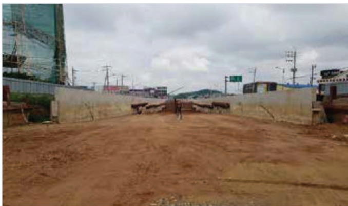
7. 전기설비 시공 후 기초 다짐
