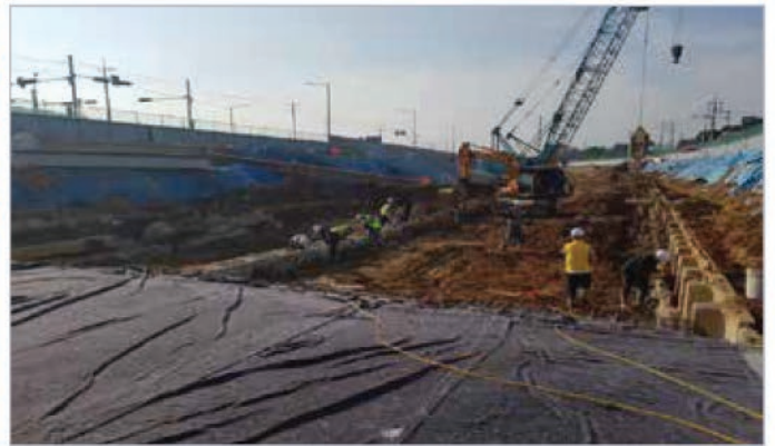
4. PC슬라브 설치 전 상부 굴착
