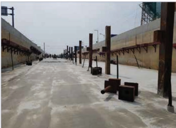
4. 하부슬래브 철근커플러 연결 및 타설
