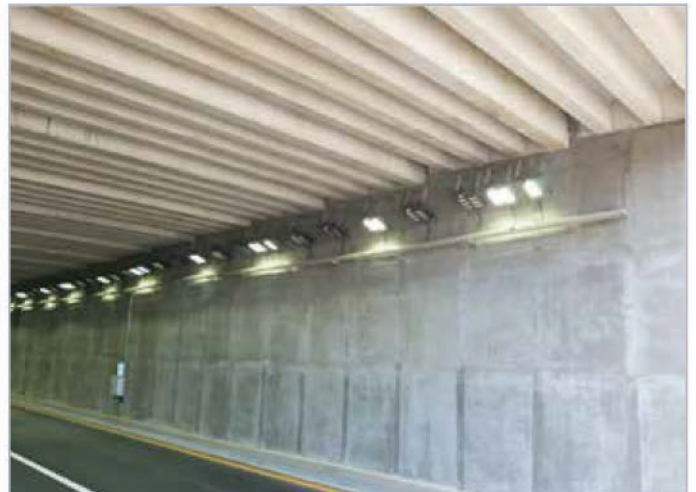
4. BOX-TYPE구간 PC-WALL 전경
