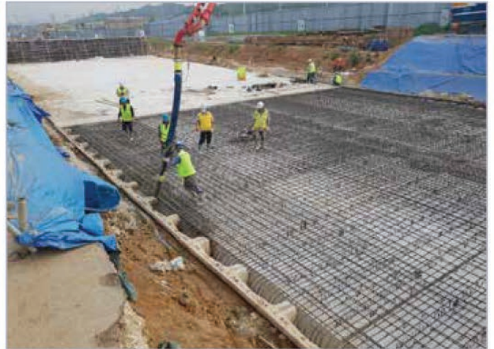
4. 상부 철근배근 및 토평콘크리트 타설
